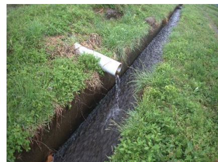
図-6 連続性のない排水路 Interrupted Drainage canal
